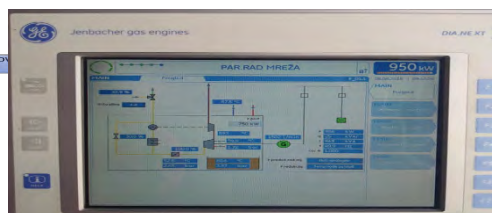
Slika 2. Podatci o radu bioplinskog motora i njegovo upravljanje
